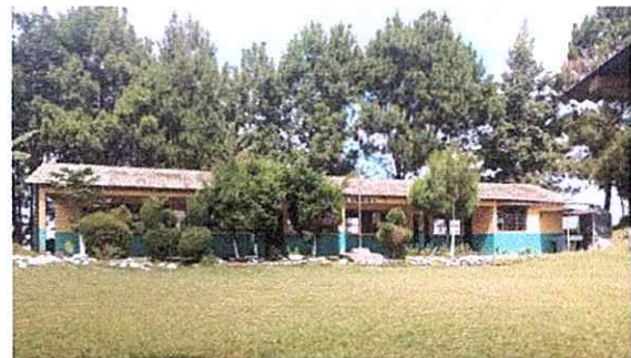
Foto 6: El centro educativo necesita de canales y bajadas de agua pluvial para abastecer la pila y el tinaco que ya se cuenta pero que es necesario también otro tinaco, por la falta de agua entubada en la comunidad.
